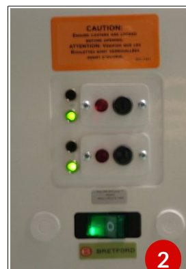
Raccordement de la salle au réseau électrique
